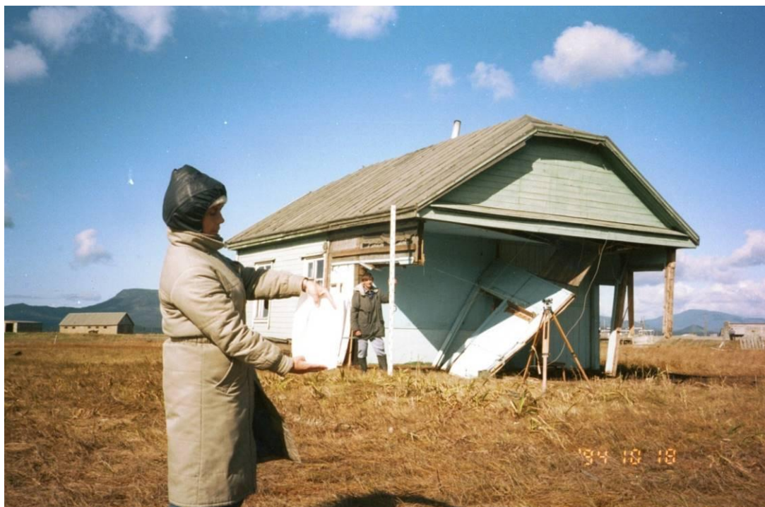
Рисунок 1.5 – Дом в Южно-Курильске, частично разрушенный и перенесенный волной цунами 4 октября 1994 г. на расстояние по прямой около 350 м [Проявления цунами 4 октября..., 1997].
