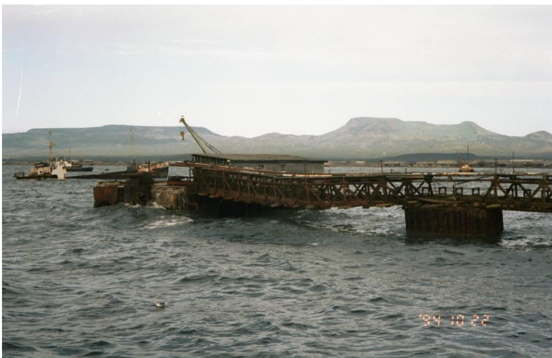
Рисунок 1.4 – Последствия цунами 4 октября 1994 г. в порту Южно-Курильска: искореженный причал и судно "Омуль", получившее при цунами повреждения вследствие удара о причал и затонувшее в бухте [Проявления цунами 4 октября..., 1997].
