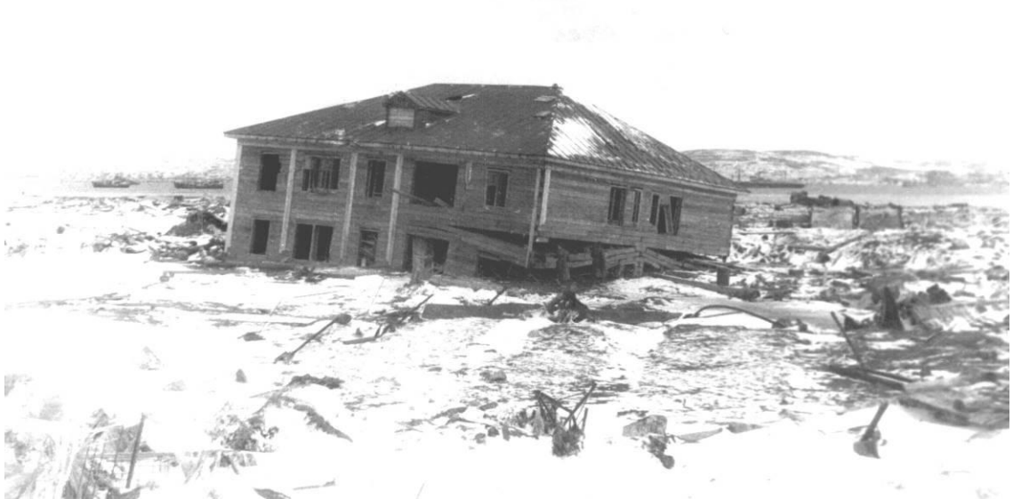
Рисунок 1.2 - Двухэтажный деревянный дом в Северо-Курильске, перенесенный цунами 5 ноября 1952 г. на другое место [ Kaistrenko and Sedaeva, 2001 ].
