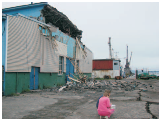
Фото 14. Разрушения в механическом цехе (автор – Кайстренко В.М.).
