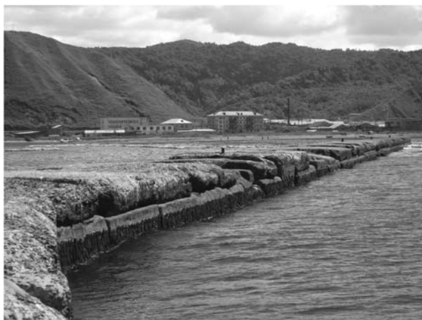
Рис. 6.19. Центральный бенч: – южный мол с морской капустой в нижней части западной стенки (фото С.А. Чиркова).
