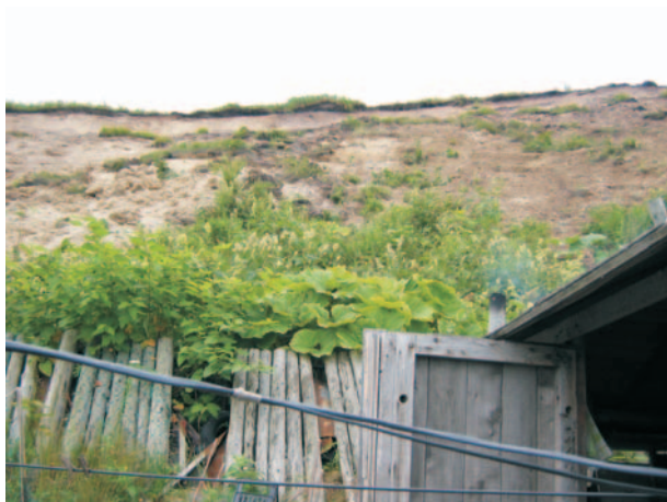
Фото 23. Оползень в районе пос.Селезнево (автор – Фокина Т.А.).
