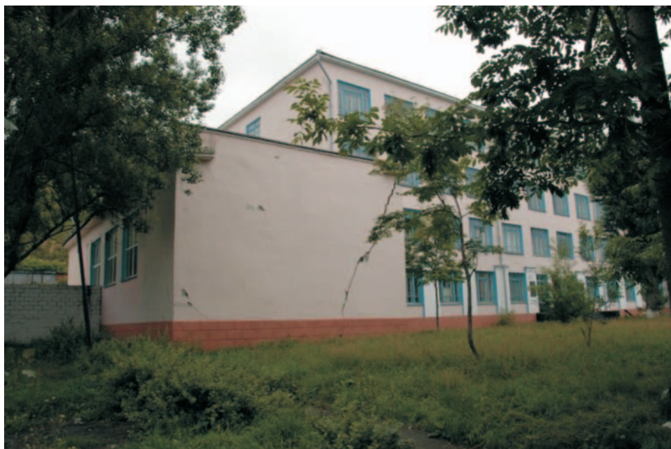
Фото 38. Трещины в широкопролетной пристройке к зданию Морского колледжа в г. Невельск. Photo 38. Cracks in the wide-span addition to the Marine College building in Nevelsk.
