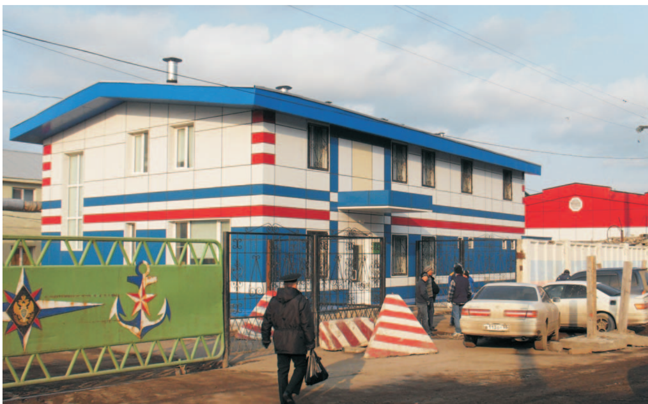
Фото 62. Здание КПП в комплексе зданий пункта управления береговой охраны (ПУБО), г. Невельск. Photo 62. Check point building shown as a part of the Coast Guard Department compound. Nevelsk.
