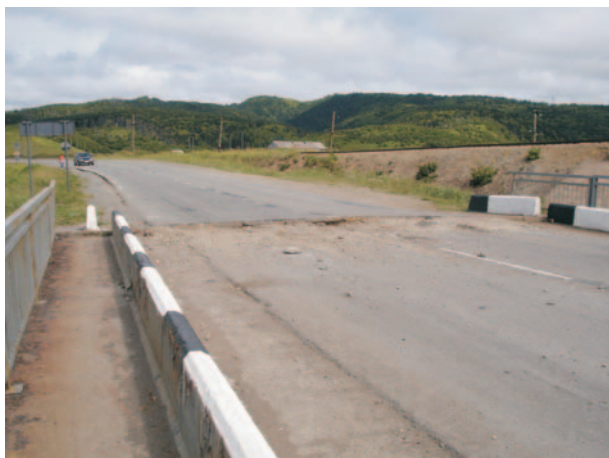
Фото 25. Сдвиг и деформация северо-восточного края автомобильного моста через р. Амурская (автор – Коваленко Н.С.).
