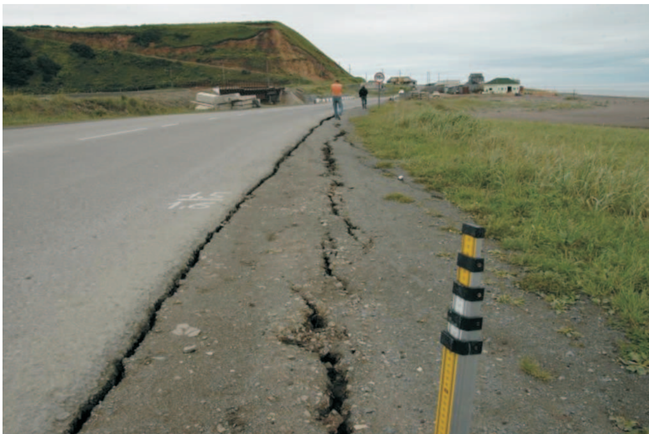
Фото 40. Кулисообразные трещины отрыва в дорожном полотне вблизи моста через р. Амурская.
