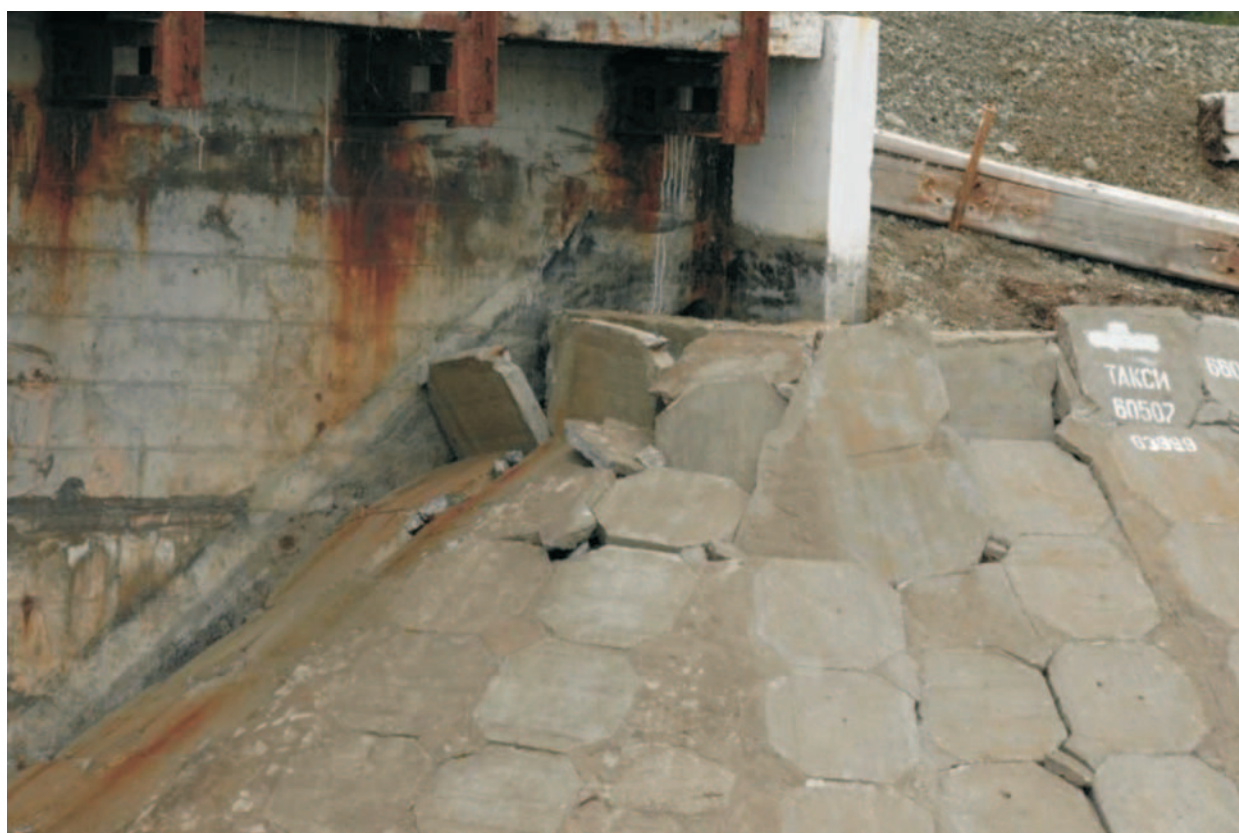
Фото 43. Деформация облицовки откоса из-за просадки грунта у южного окончания железнодорожного моста через р. Амурская.
