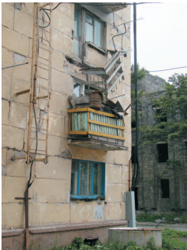
Фото 20. Внешние повреждения жилого дома №109 по ул. Рыбацкой в г. Невельск (автор – Кайстренко В.М.).
