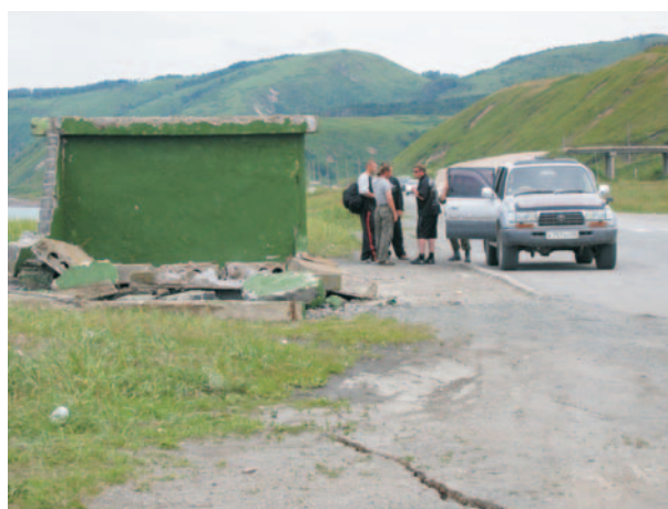
Фото 28. Полуразрушенная автобусная остановка в районе моста (автор – Урбан Н.А.).
