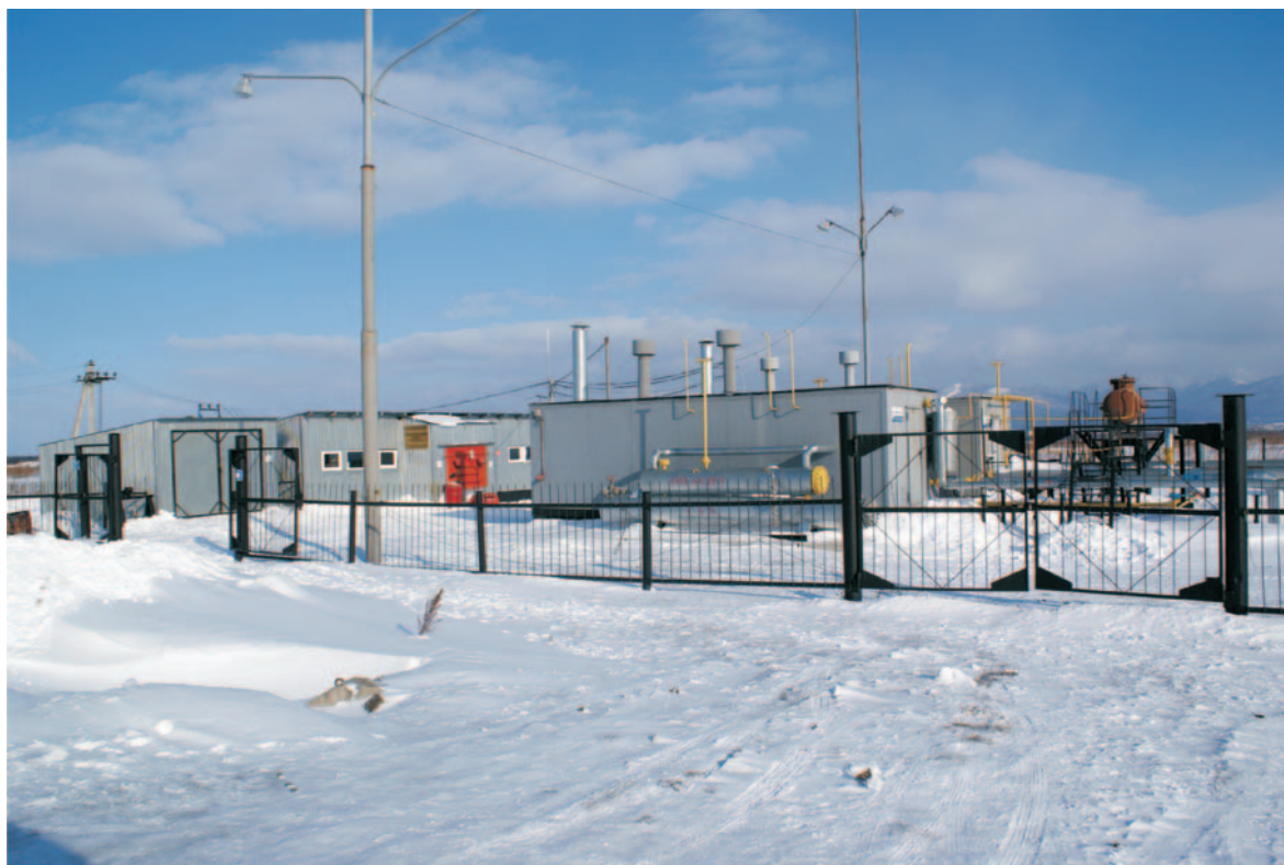
Фото 66. Очистные сооружения, г. Невельск.
