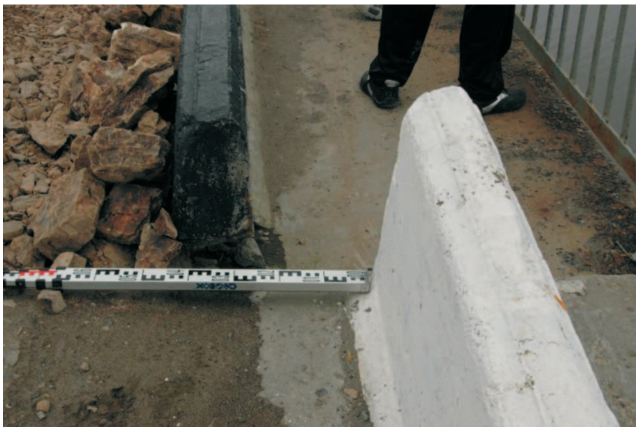
Фото 41. Сдвиг северо-восточного края автомобильного моста через р. Амурская на 45 см.
