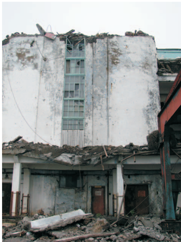
Фото 17. Разрушения здания портнадзора (автор – Кайстренко В.М.).
