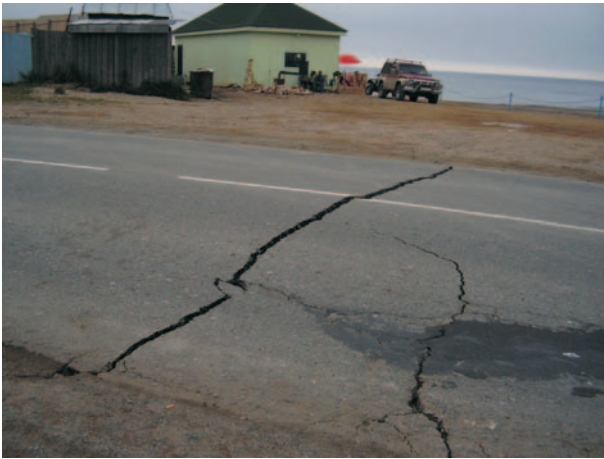
Фото 31. Трещины в районе пашлычной (автор – Кайстренко В.М.).
