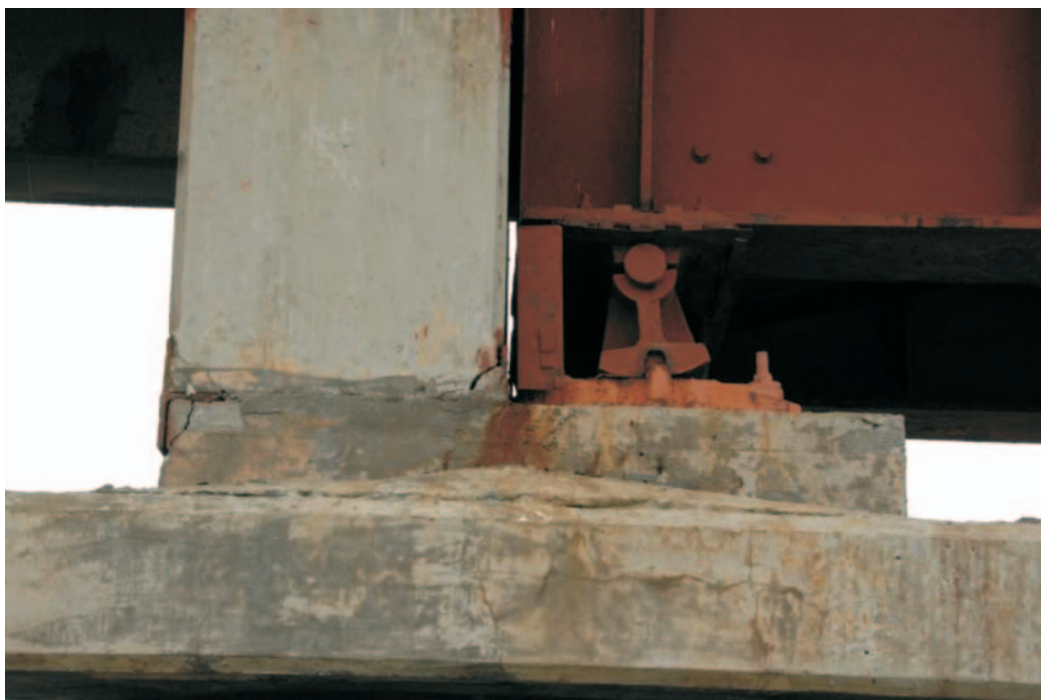
Фото 44. Трещины в бетонной опоре из-за горизонтального удара металлического пролетного строения ж/д моста. Видна наклонившаяся качающаяся опора.
