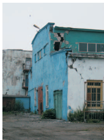
Фото 15. Повреждения здания электроцеха (автор – Кайстренко В.М.).
