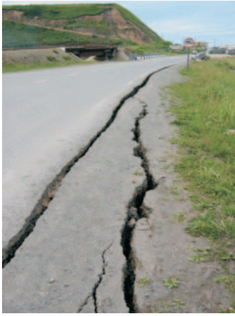
Фото 29. Поперечная трещина вдоль дорожного полотна (автор – Урбан Н.А.).
