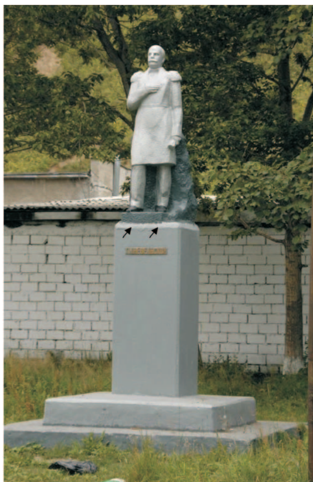
Фото 39. Памятник Невельскому у здания Морского колледжа (трещина показана стрелками). Photo 39. G.I. Nevelskoy's monument near the Marine College building in Nevelsk. (The crack is shown by arrows).
