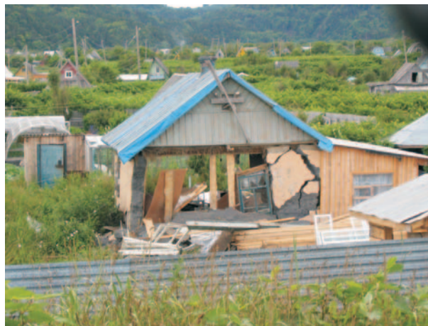
Фото 24. Разрушение жилых домов по ул. Набережной в пос. Лопатино (автор – Фокина Т.А.).
