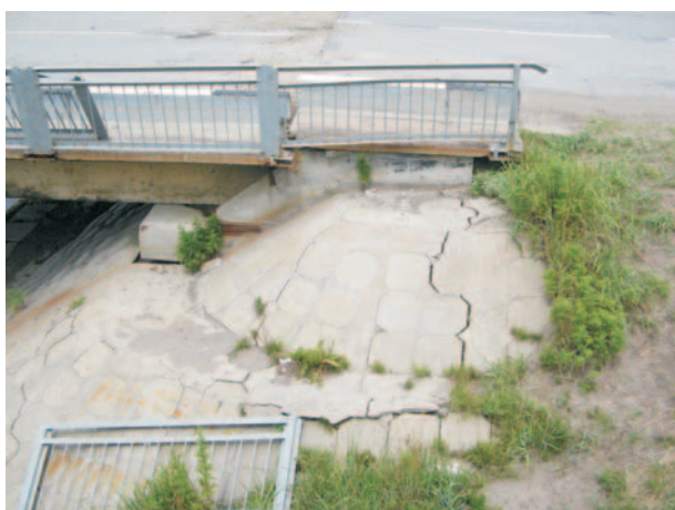
Фото 27. Разрушение облицовки откоса моста (автор – Урбан Н.А.).
