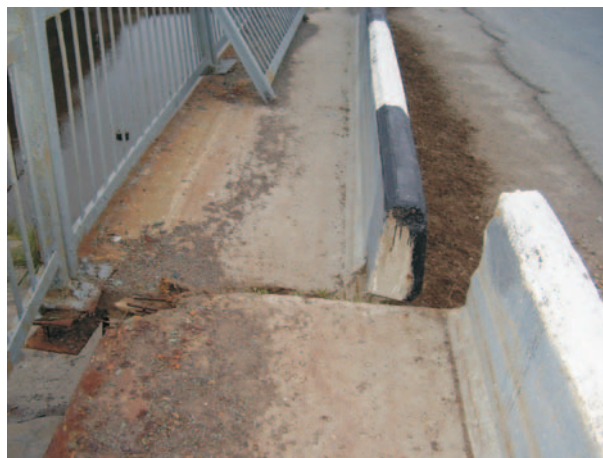
Фото 26. Характерное разрушение автомобильного моста через р. Амурская (автор – Коваленко Н.С.).
