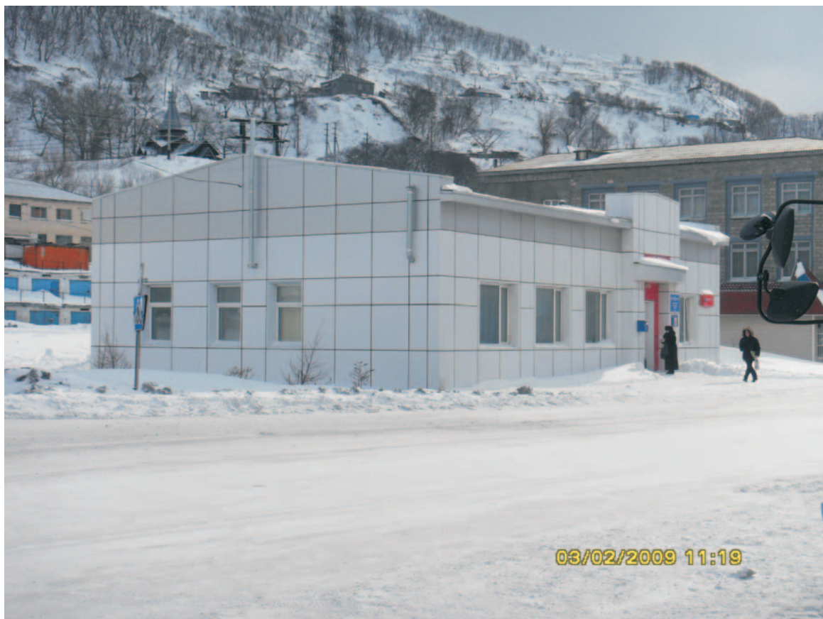
Фото 60. Здание центрального отделения почтовой связи, г. Невельск.
