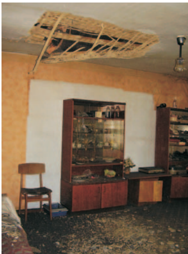
Фото 33. Потолок, пробитый упавшей трубой (г. Горнозаводск) (автор – Коваленко Н.С.).
