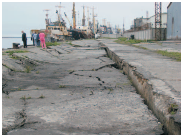
Фото 12. Разрушения на причалах №№ 4–9 Невельского порта (автор – Кайстренко В.М.).
