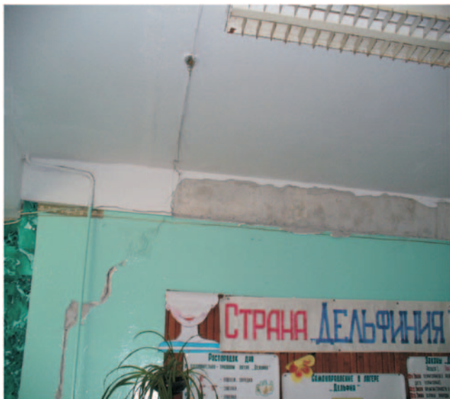
Фото 4. Трещины в штукатурке недавно отремонтированного здания интерната в пос. Горнозаводск (автор – Шестакова О.М.).
