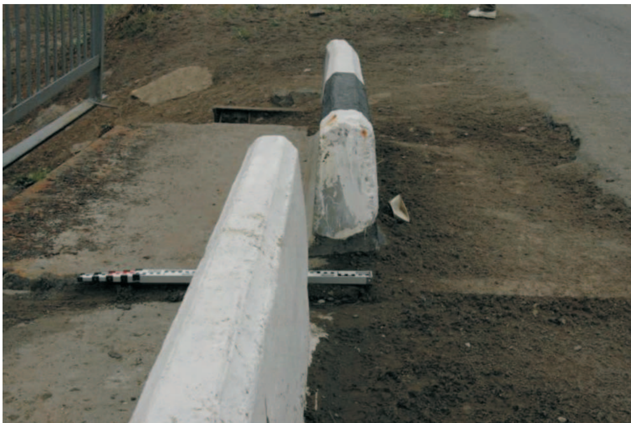
Фото 42. Сдвиг юго-западного края автомобильного моста через р. Амурская на 20 см.
